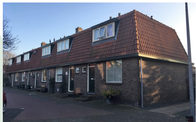
Woningen in de Bloemenbuurt vóór de renovatie. (Aalbrechts bouw)
